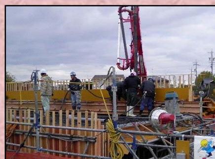
コンクリートの打設状況
