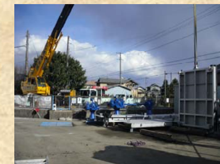
ゲートの据付状況
