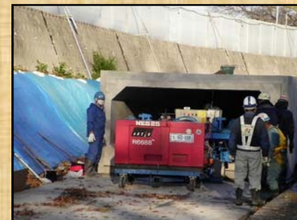
ボックスカルバート据付状況
