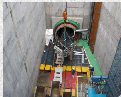
発進立坑の作業状況 発進立坑から用水路の工事資材となるセグメントを運び入れています
