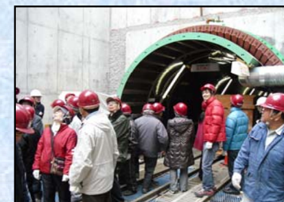
シールドトンネル坑口
