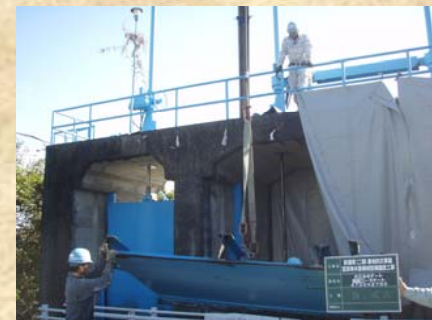
旧ゲートの撤去状況
