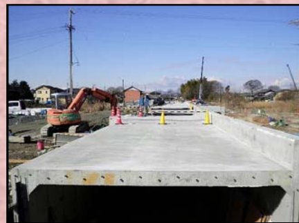
暗渠本体の完成
