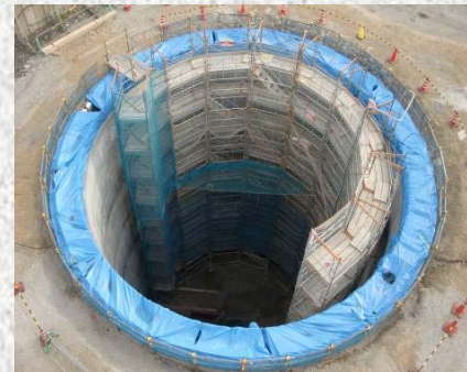
到達立坑のようす 立坑の下部構造が完成しました
