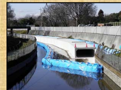
据付完了状況
