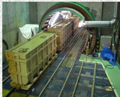
サイホンの作業状況 掘削した土砂を台車に乗せて搬出しています。
