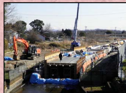
用水路（暗渠）の施工状況
