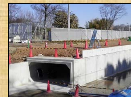
盛土完了状況
