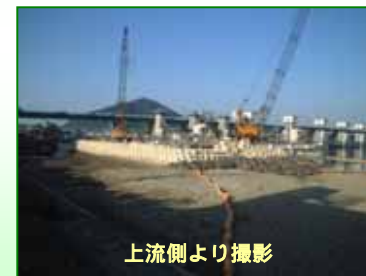
犬山頭首工・第6期締切補修工事のようす（河川を締め切る準備をしています）
