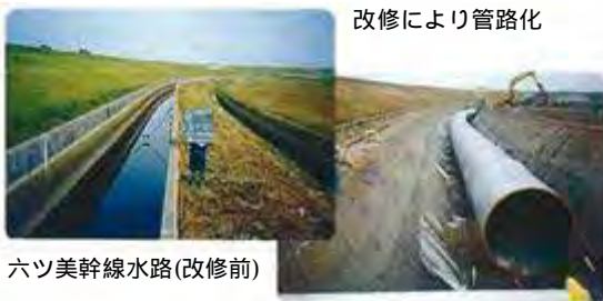
改修により管路化
