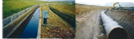
六ツ美幹線水路(改修前)
