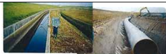
六ツ美幹線水路(改修前)
