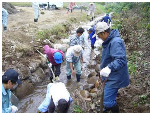
プレハブ水路から石積み水路へ改修
