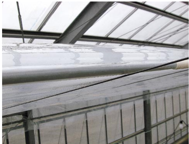
図4 空気膜が膨らんだ状態
