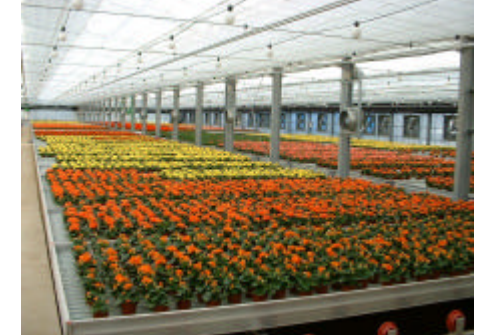
施設内部（底面吸水式移動ベンチ）
