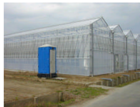
複合経営施設全景
