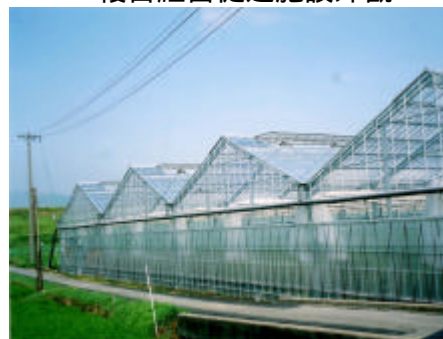
複合経営促進施設外観
