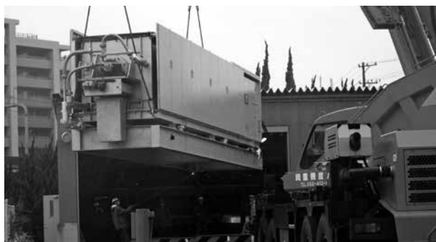
【殺菌ユニットのクレーン2台による吊上げ状況】
