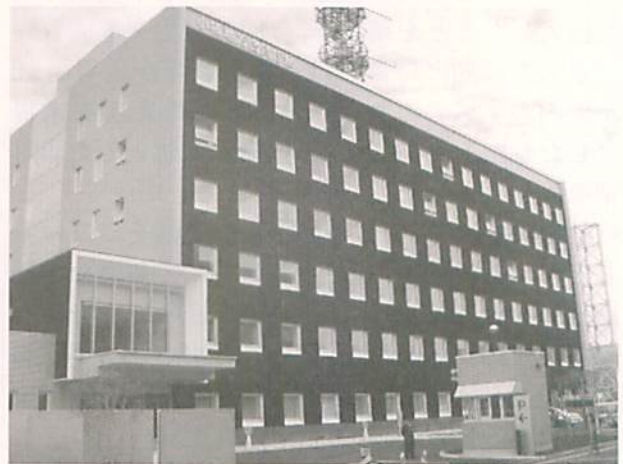
【小樽地方合同庁舎】
