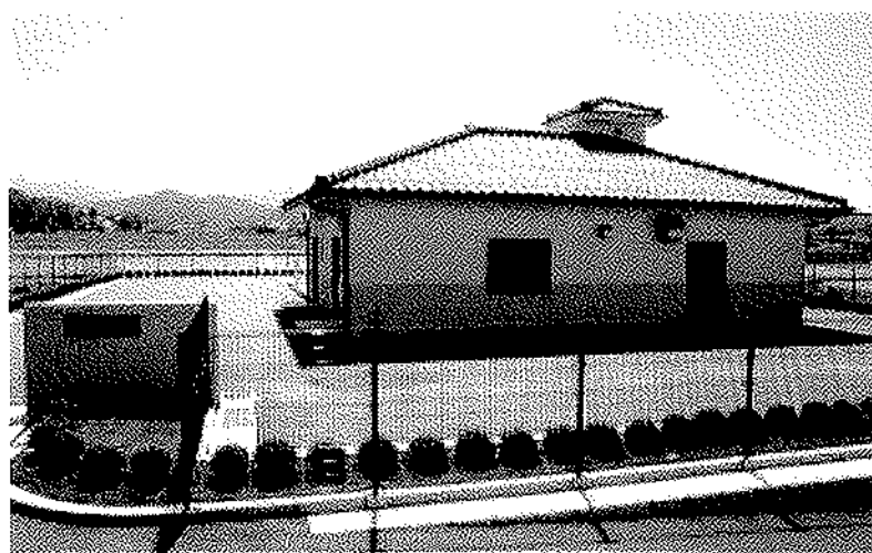
農業集落排水処理施設の施工例
