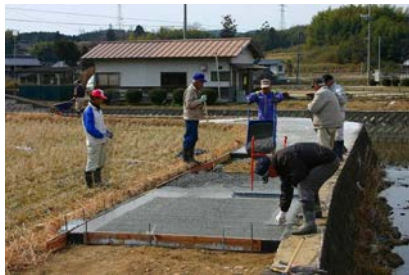
自主施工による農道舗装
