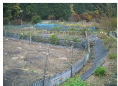
直営施工の鳥獣被害防止柵
