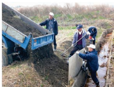
自主施工による水路法面の補修
