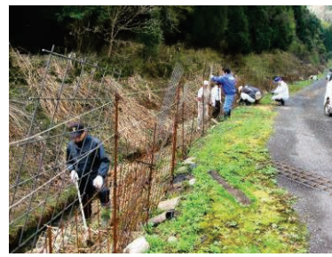
老朽化した鳥獣害防止柵の補修
