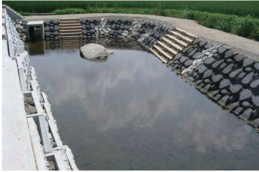
ビオトープの施工
