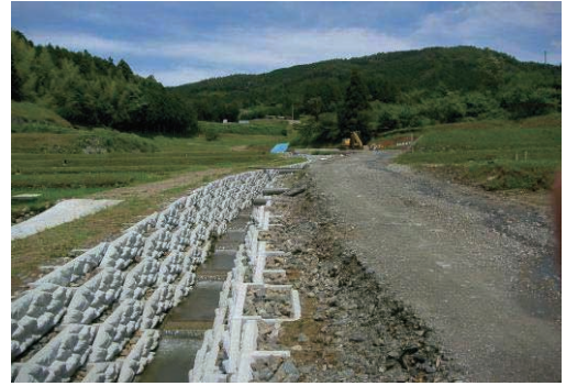
環境に配慮した護岸の施工
