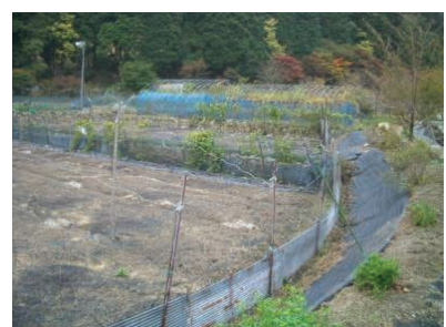
直営施工の鳥獣被害防止柵
