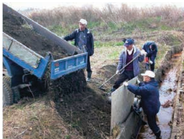
自主施工による水路法面の補修
