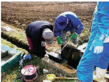
自主施工による破損した水路の補修
