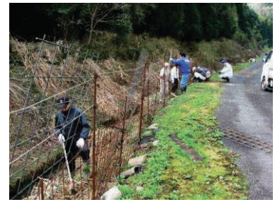
老朽化した鳥獣害防止柵の補修
