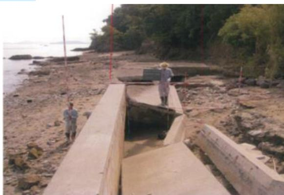
海岸堤防の損壊 (台風第11号・香川県三豊市<sup>みとよ</sup>)
