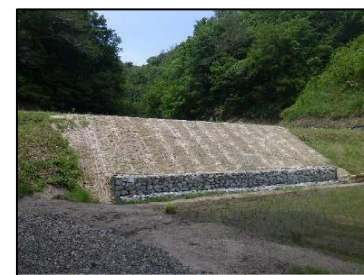
法面崩落（島根県奥出雲町） 左：被災後 右：復旧後
