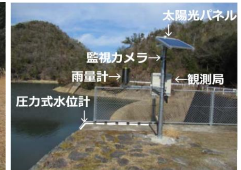
遠隔監視機器の設置
