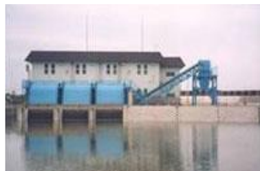
排水機場の整備
