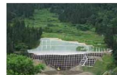
地すべり対策工事の完了
