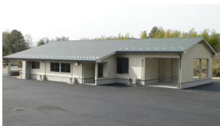
< 処理施設の外観 >
