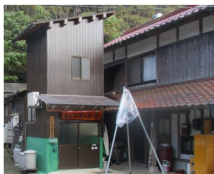
< 処理施設の外観 >
