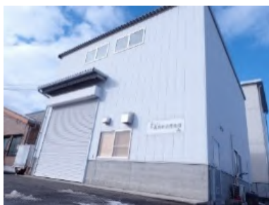
< 処理施設の外観 >
