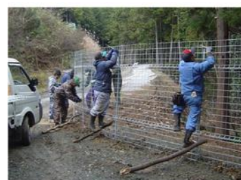
侵入防止柵の設置
