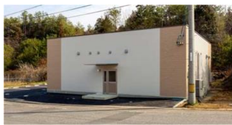
<東広島市有害獣処理加工施設>
