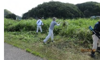
緩衝帯の整備
