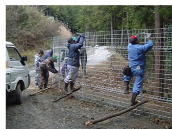
侵入防止柵の設置
