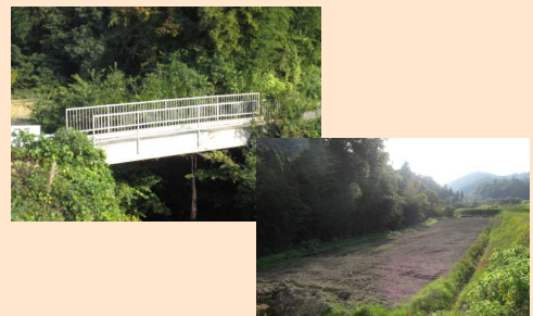
架け替えた農道橋及び再生利用された農地
