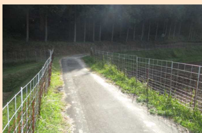
交付金を活用した農道舗装
