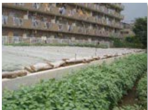
土砂流出対策の土留め
