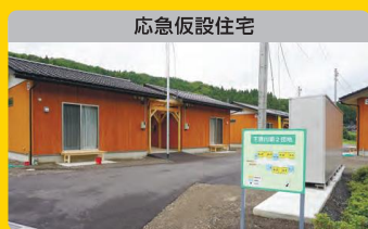
応急仮設住宅
