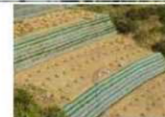
傾斜の途中に土留工(かご枠)を設置し、緩傾斜地化
