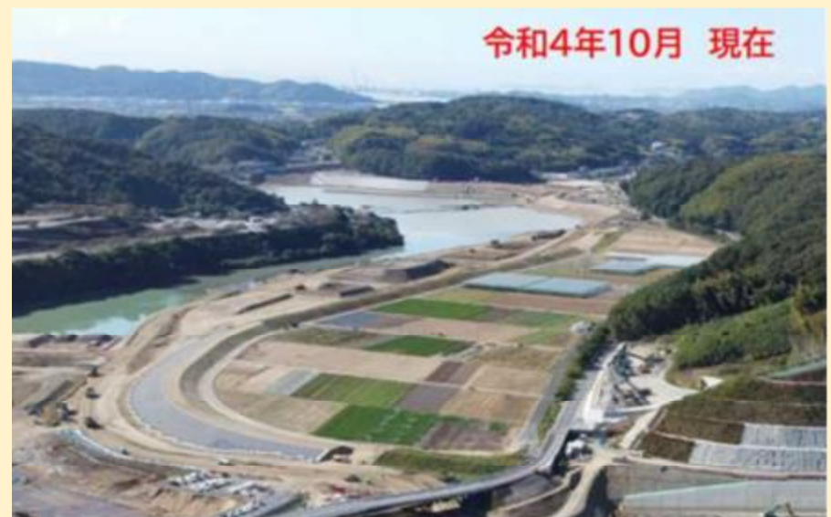
【写真3 ほ場整備実施後の様子】
