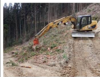
【林業機械による地拵え】
