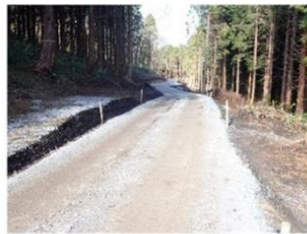
【林業専用道新設】
