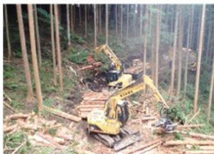
【高性能林業機械での組合せ作業】
