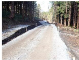
【林業専用道新設】
