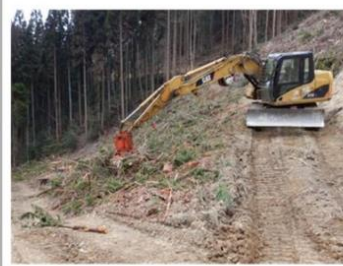
【林業機械による地拵え】
