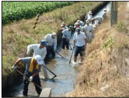
水路の泥上げ
