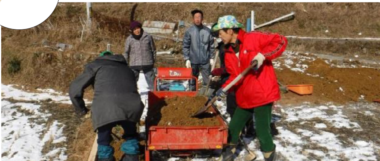
畦の修繕作業
