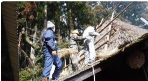
古民家の修繕活動
