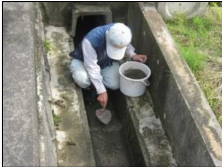
施設の軽微な補修
