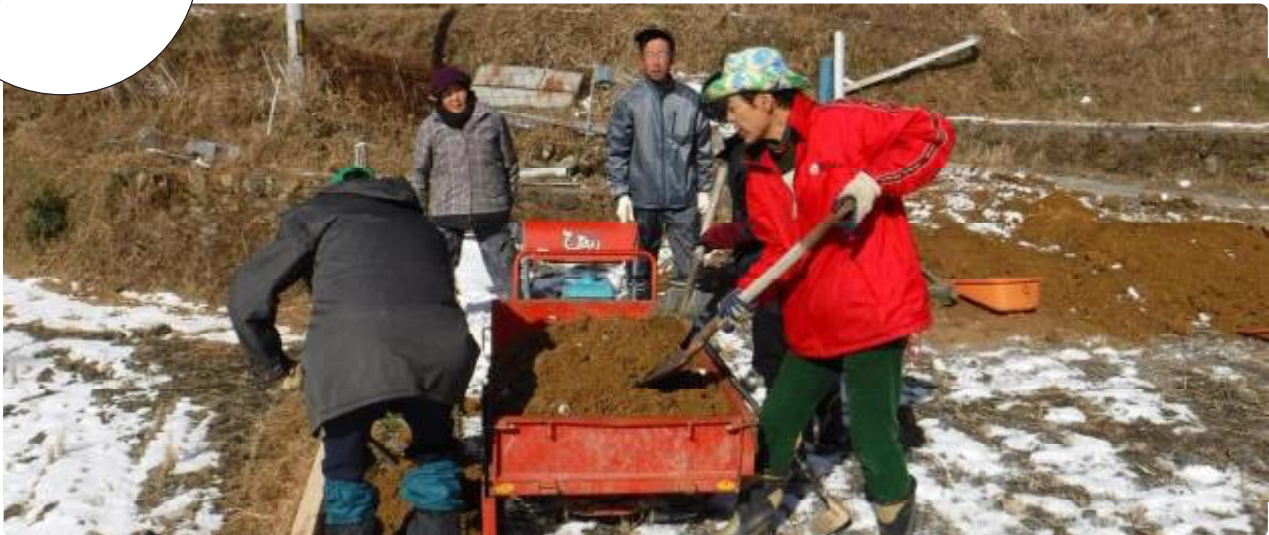
畦の修繕作業
