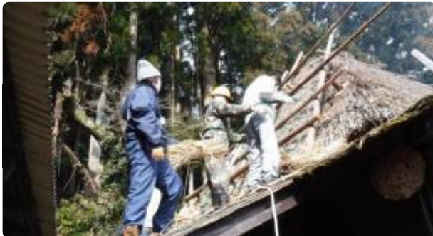
古民家の修繕活動
