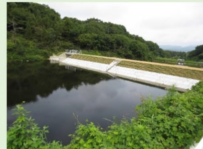
【ため池の補強対策】 法面保護による堤体の浸食防止
