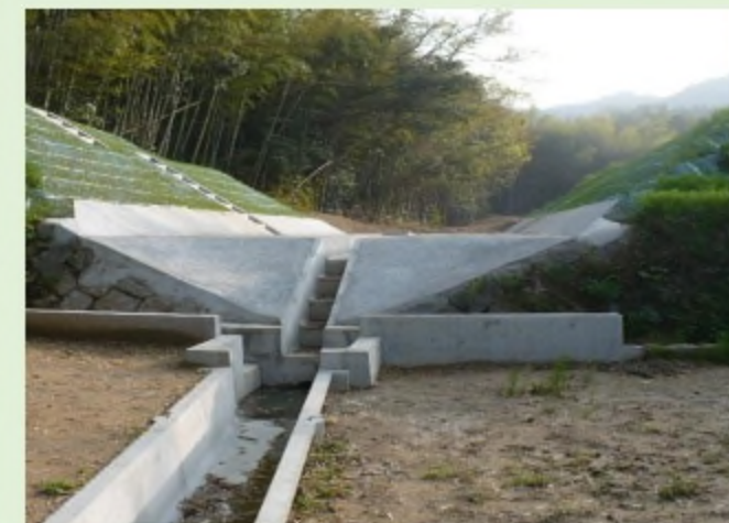
【ため池の廃止】 堤体開削による貯水機能の喪失
