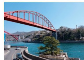
音戸の瀬戸に架かる音戸大橋(手前が音戸)
