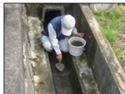
施設の軽微な補修
