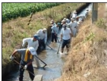
水路の泥上げ
