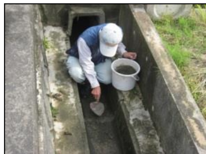
施設の軽微な補修
