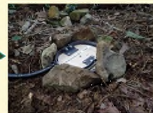
③塩ビ管の上に踏み板をセット
