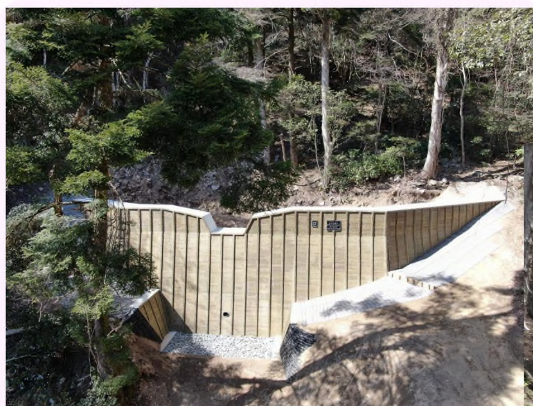
【溪間工事：臥牛山国有林(高梁市)】
