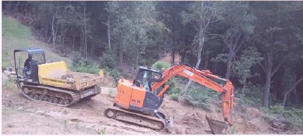
(資材運搬車両への資材積込状況)
