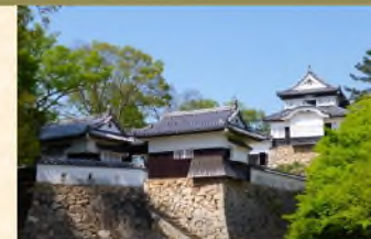
【国有林に接する備中松山城(高梁市)】
