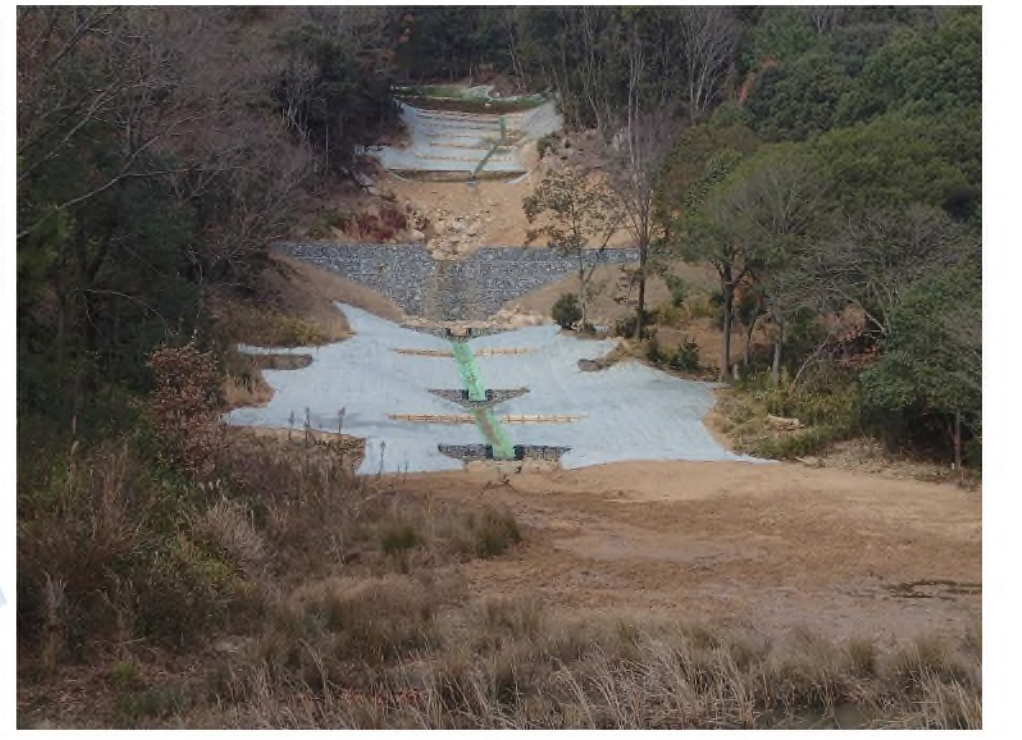
【緑化基礎工、緑化工：丸太筋工、植生土のう筋工、植生ネット伏工(R2)】
