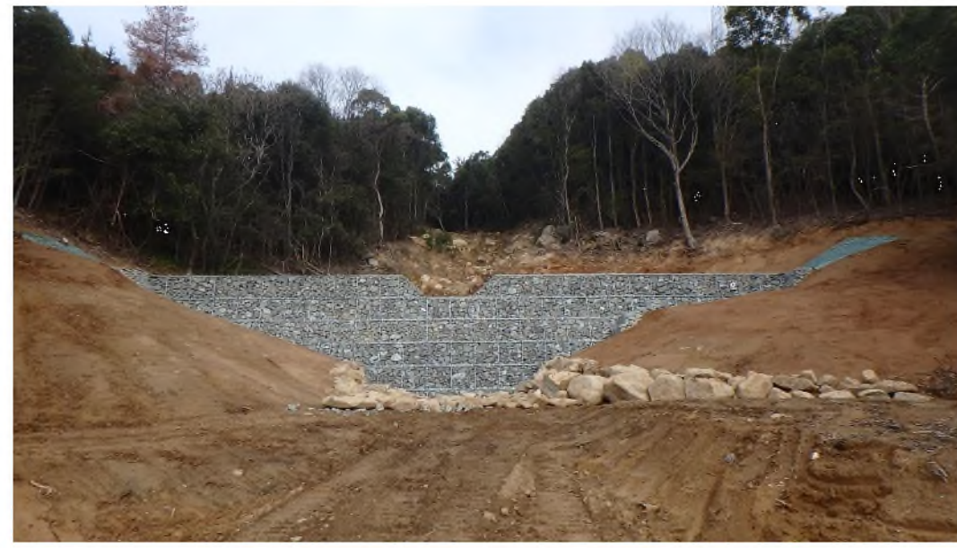
【基礎工：鋼製網谷止工(R元)】
