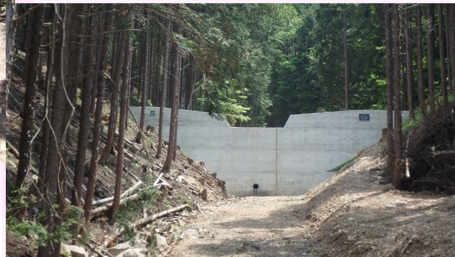
【溪間工事：黒木国有林(津山市)】
