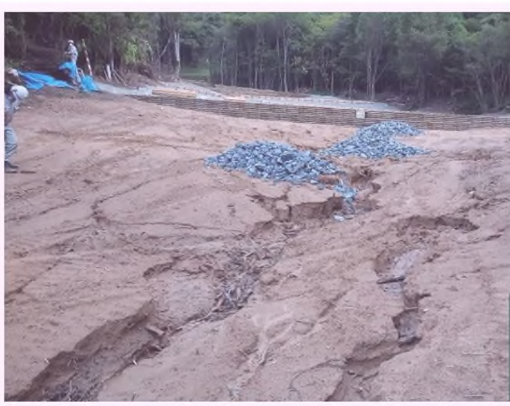
(丸太筋工施工状況) (令和3年8月集中豪雨により再び被災)
