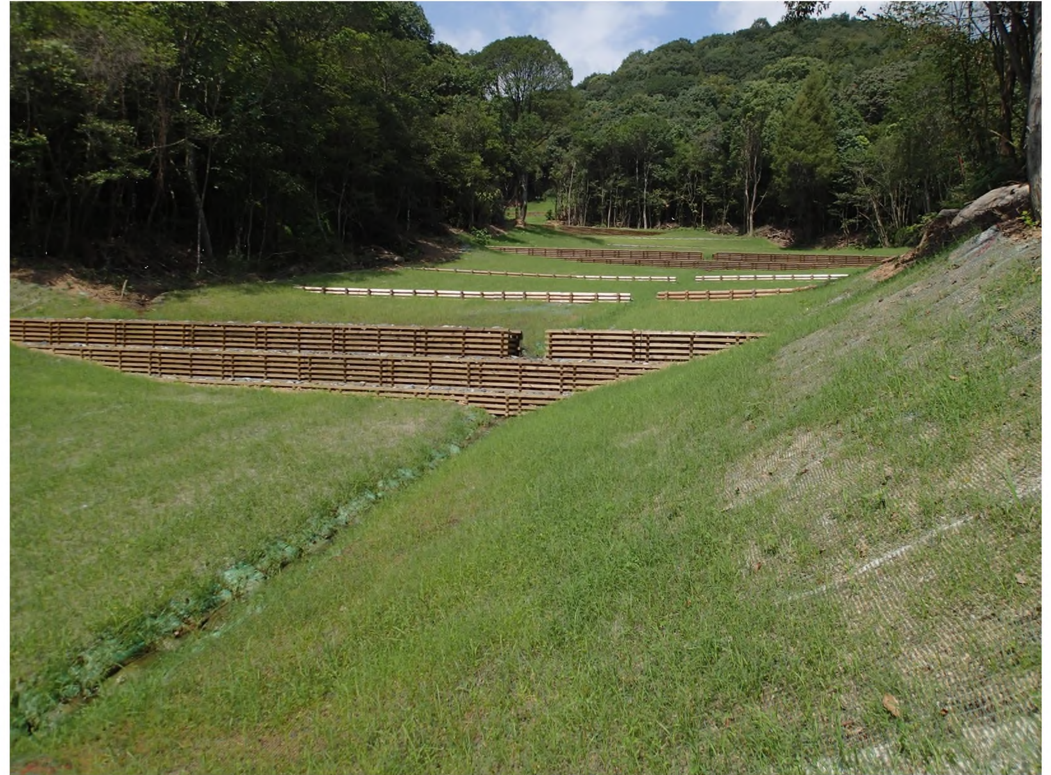
【山腹工事完了状況：加賀山国有林(浅口市)(R3)】
