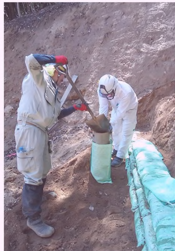
(植生土のう筋工施工状況)
