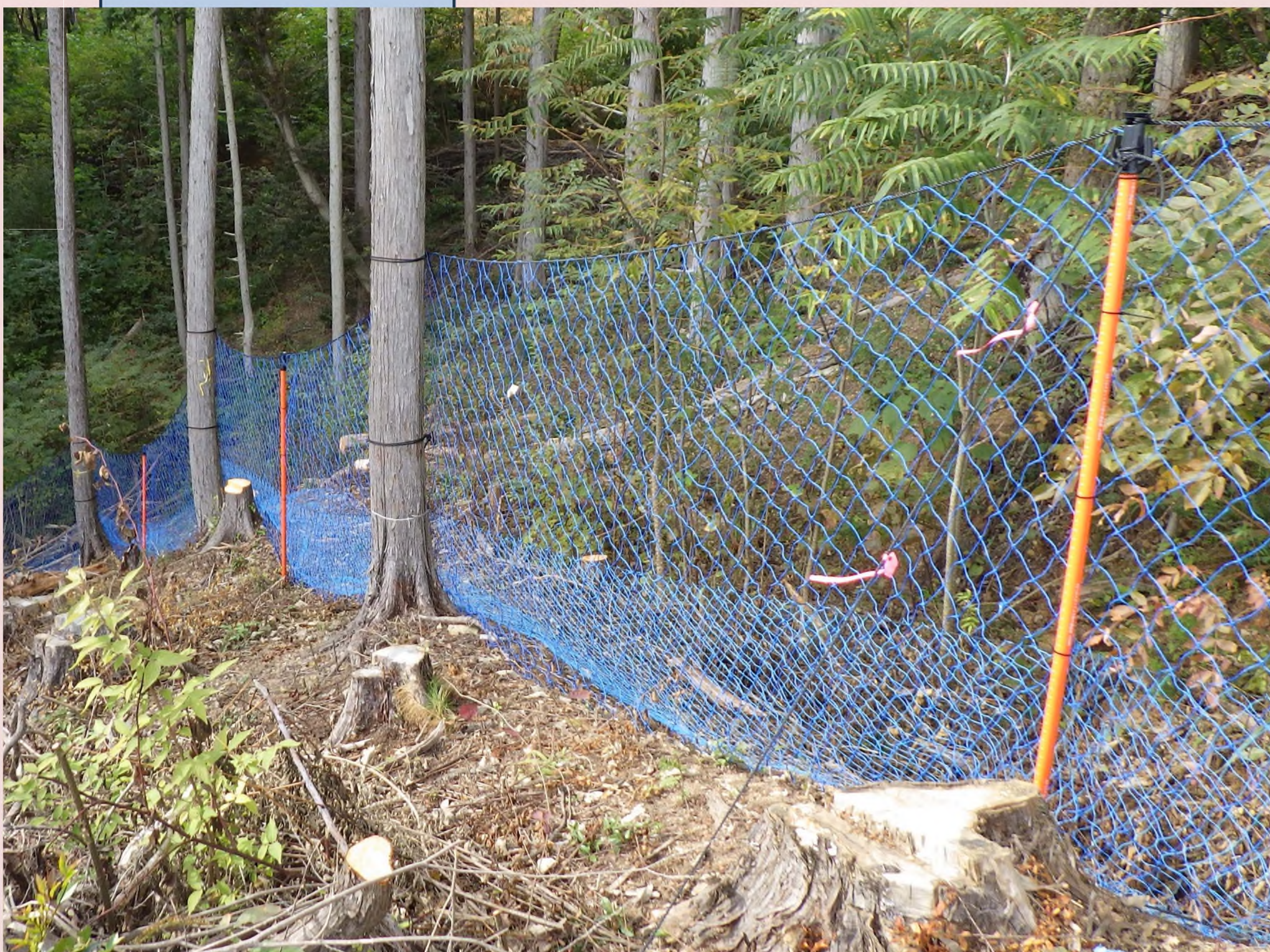
【立木を活用した防護柵：高太郎国有林（新見市）】
