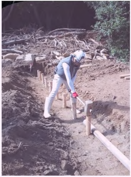
(丸太筋工施工状況) (令和3年8月集中豪雨により再び被災)
