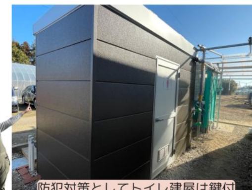
防犯対策としてトイレ建屋は鍵付
