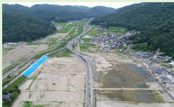
農地への土砂流入状況 (平成30年7月豪雨)
