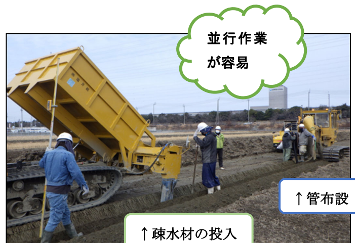
【管布設と疎水材の投入を並行で行う様子】
