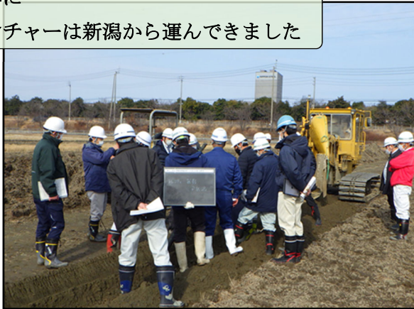
【トレンチャー掘削を見学している様子】
