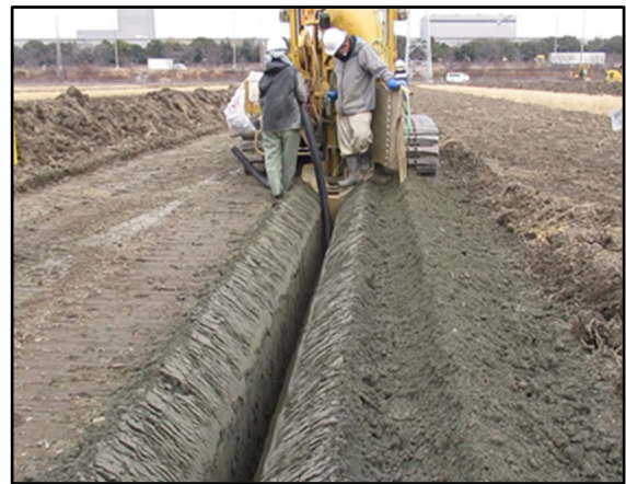
【トレンチャー掘削と吸水管布設】
