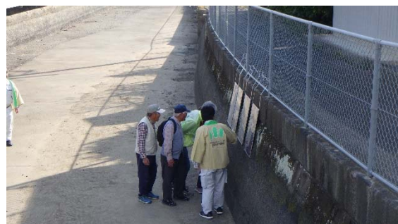
【北岸幹線水路内】
