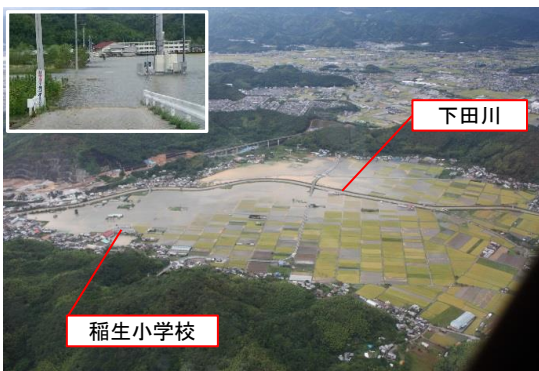
湛水被害状況 (平成26年8月豪雨)
