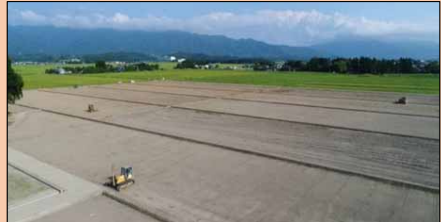
平場の大区画整備などでは0.3ha以上の施工単価を適用
