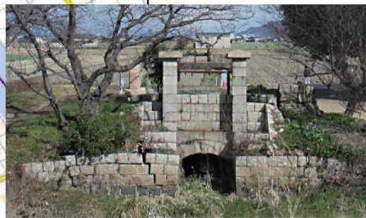
⑦宮川樋門
