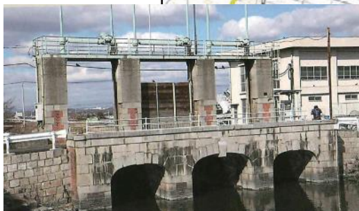
③丙川三連樋門
