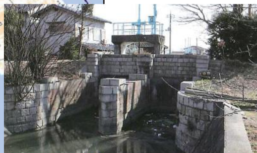
⑧奉還樋門
