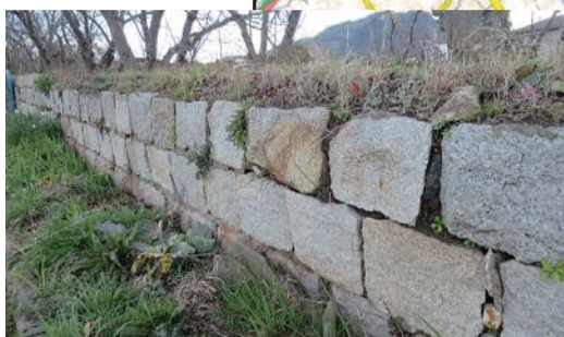
②第二号干拓堤防
