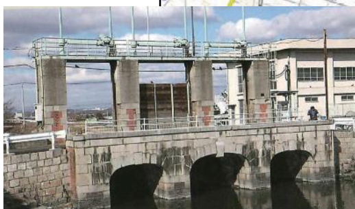
③丙川三連樋門
