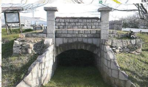
⑥常川樋門
