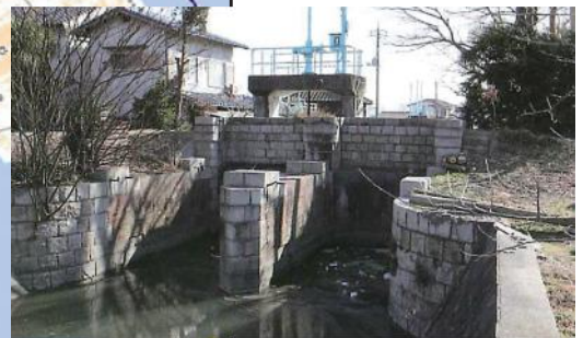
⑧奉還樋門
