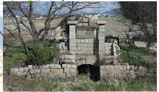
⑦宮川樋門
