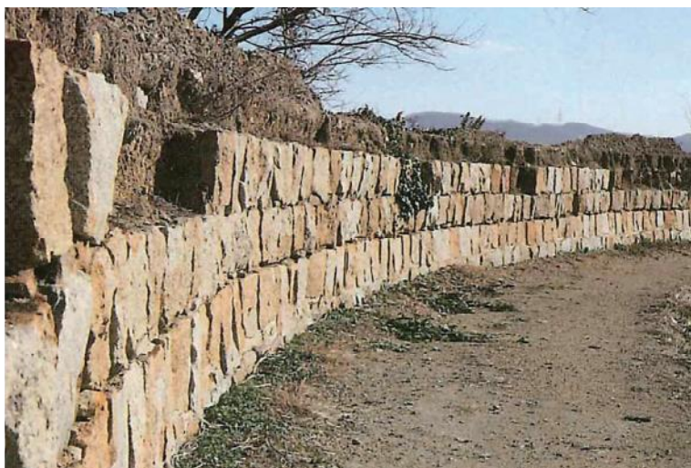
第一号干拓堤防
